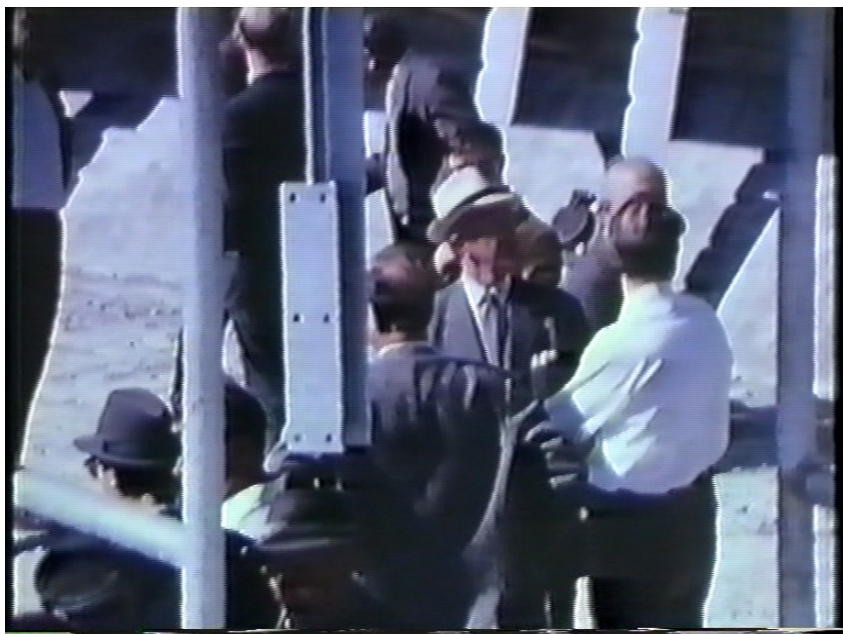
Sognerådet besigtiger det igangværende byggeri (1964)
